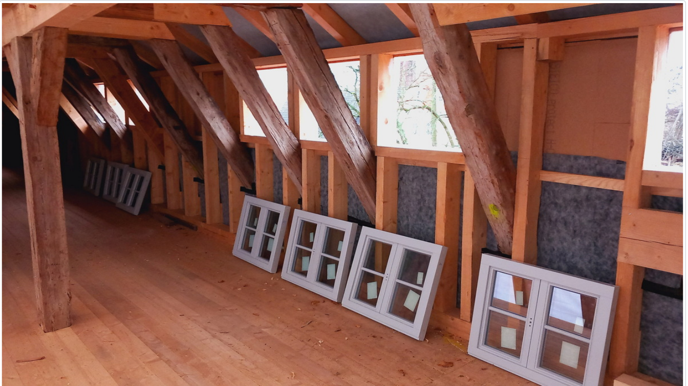
Die Gaupenfenster stehen bereit, um eingebaut zu werden. In dieser Woche war es so weit. © Jörg Richter
