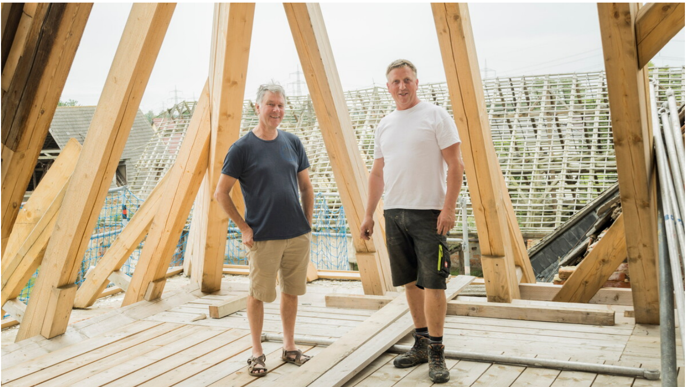
Henry de Jong und Zimmerer Mike Aust im sanierten Dachstuhl des Torhauses im Rittergut Tiefenau. Im Hintergrund: Das Scheunendach, dessen Sanierung nun folgen soll. © Eric Weser
