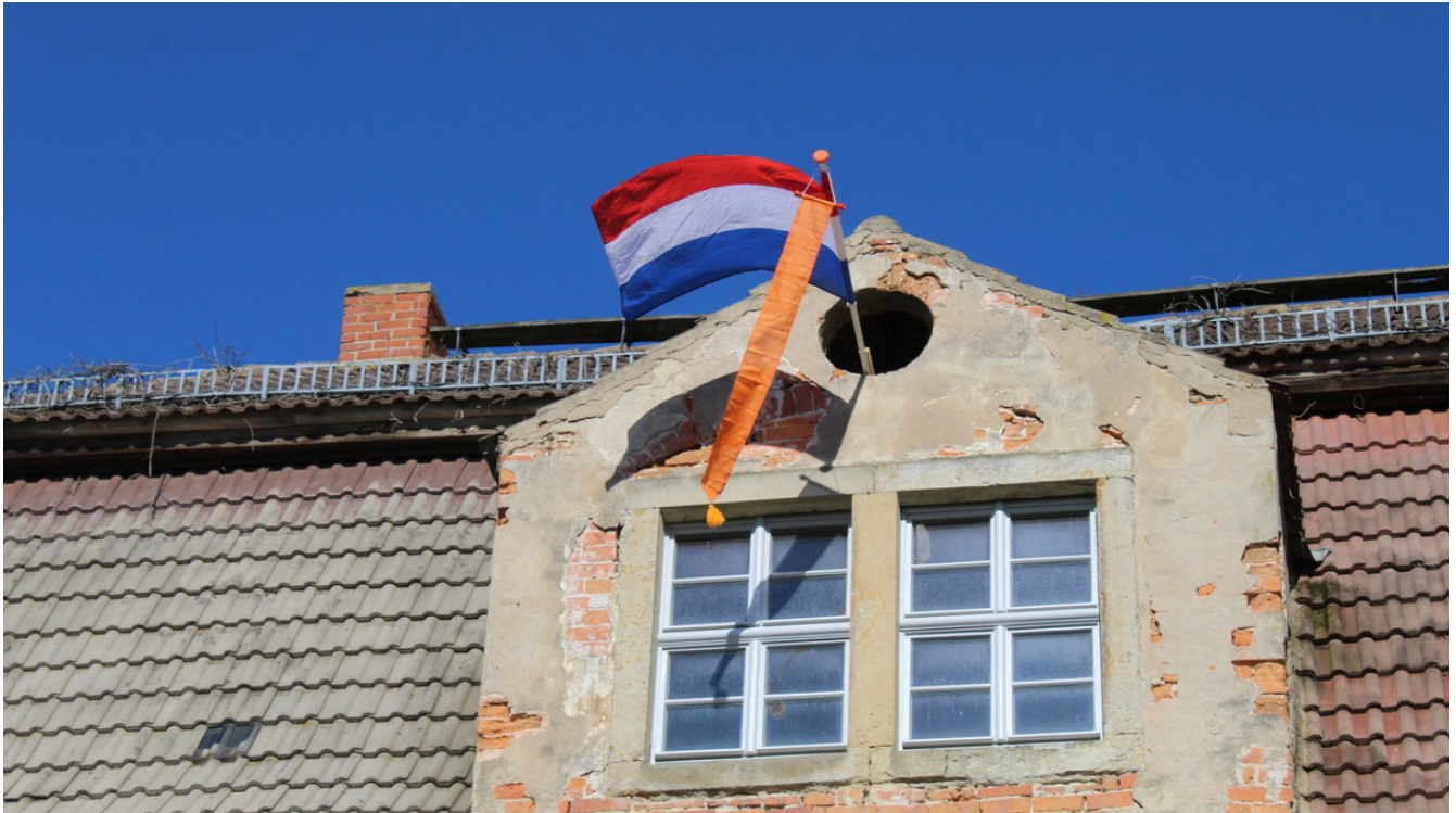
Aus einem Gaupenfenster an der Schlossfassade in Tiefenau weht die holländische Flagge. © Jörg Richter
