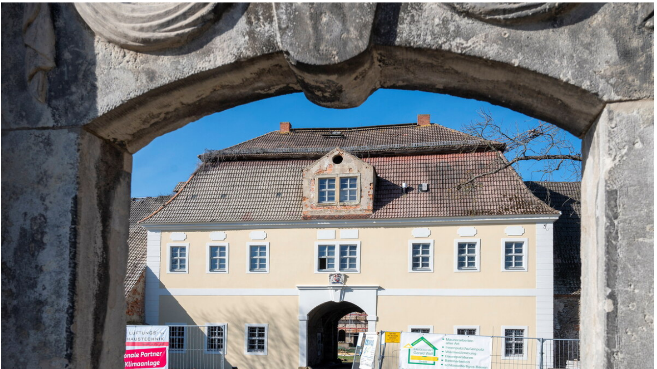
Die Fassade am östlichen Torhaus des Tiefenauer Ritterguts ist neu geputzt und gestrichen. © Klaus Dieter Bruehl
