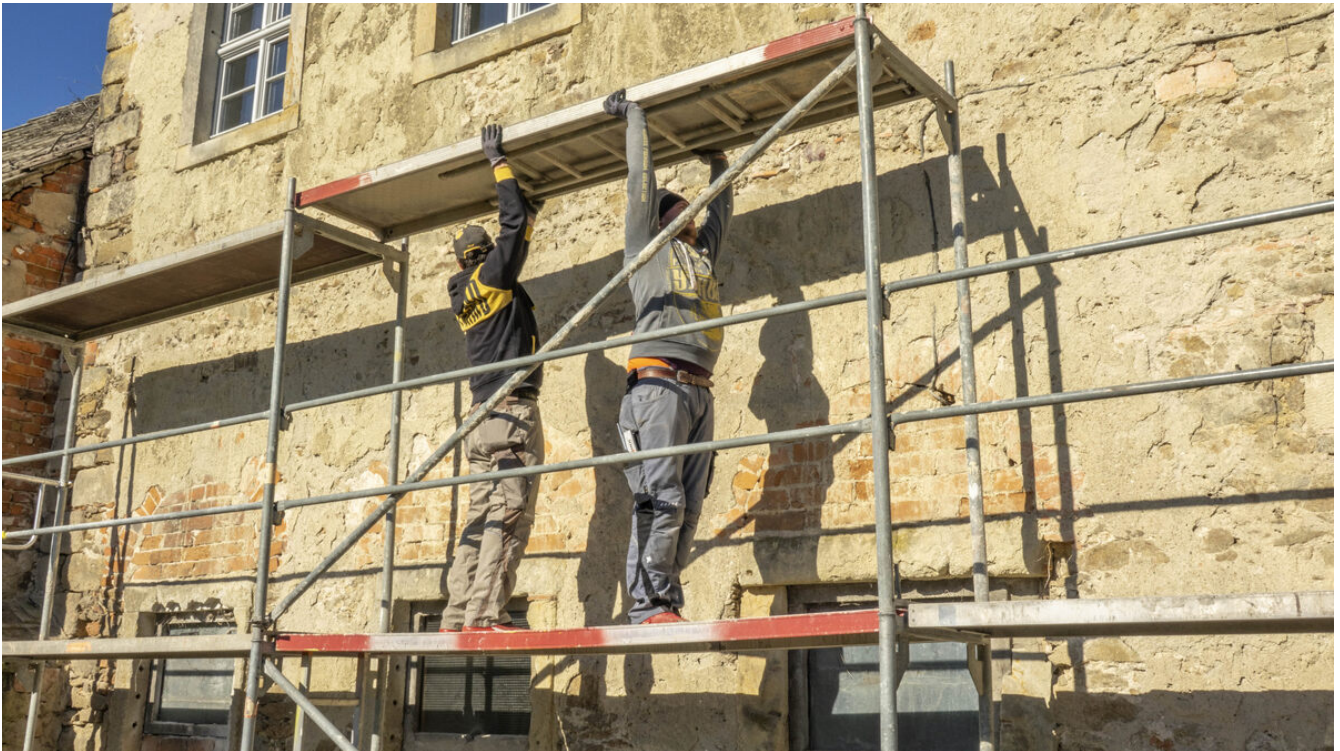
Das Gerüst vor dem östlichen Torhaus wird aufgebaut. © Lutz Weidler
