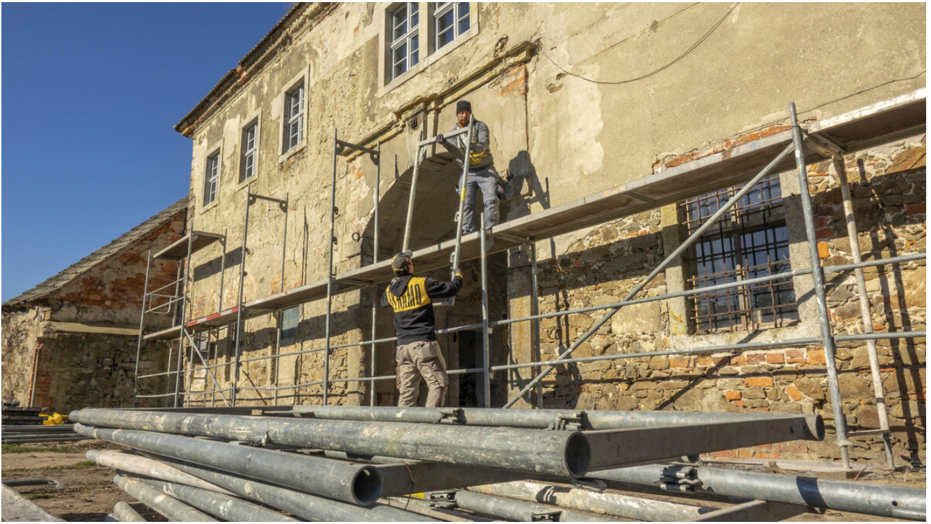
Wenn das Gerüst hier fertig ist, soll es am westlichen Torhaus weitergehen. © Lutz Weidler
