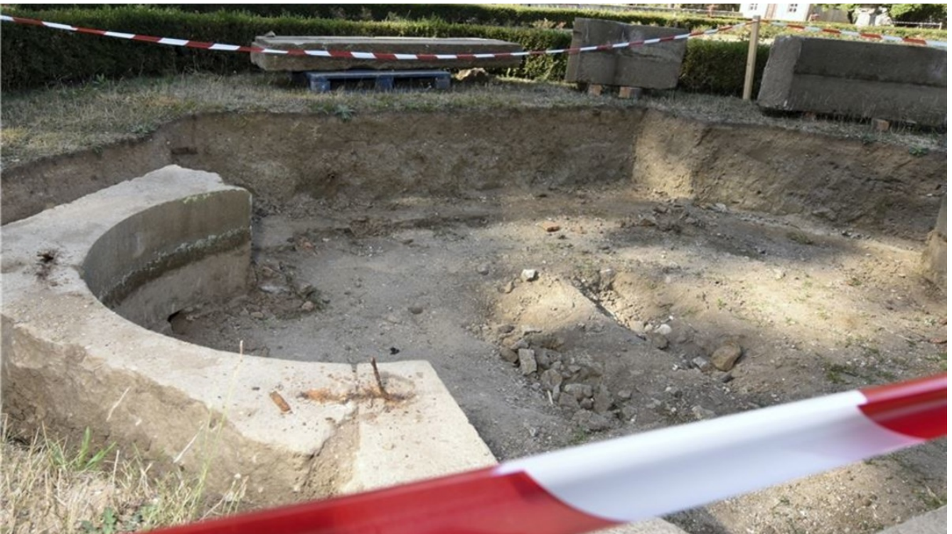
Ausgebaut: Dieser Brunnen ist bereits demontiert. Die Anlage soll ein neues Fundament erhalten, abgedichtet und anschließend neu montiert werden. © Klaus-Dieter Brühl
