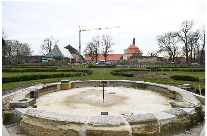
Heute: Der Mittelbrunnen wird bald in alter Schönheit erstrahlen. Und auch das Schloss soll 2024 wieder aufgebaut werden. © Holm Helis
